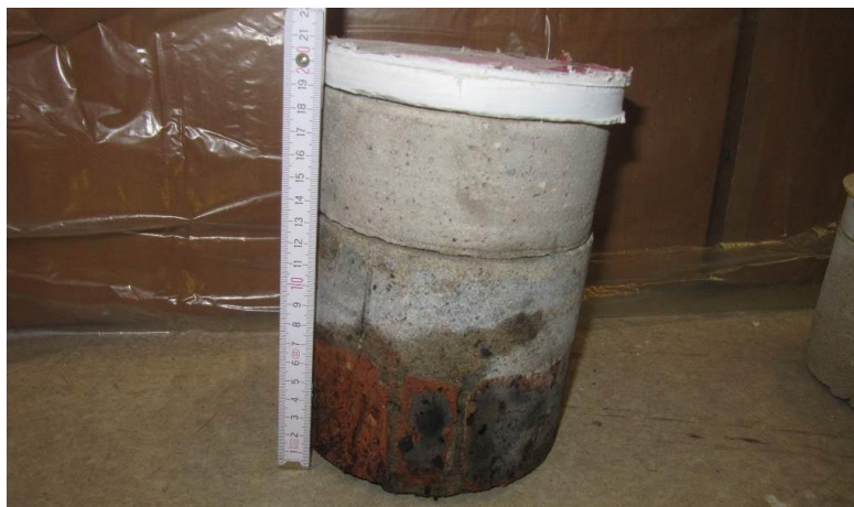
Rys. 7. Warstwy podłogi w odwiercie rdzeniowym w podłodze pomieszczenia nr 005
