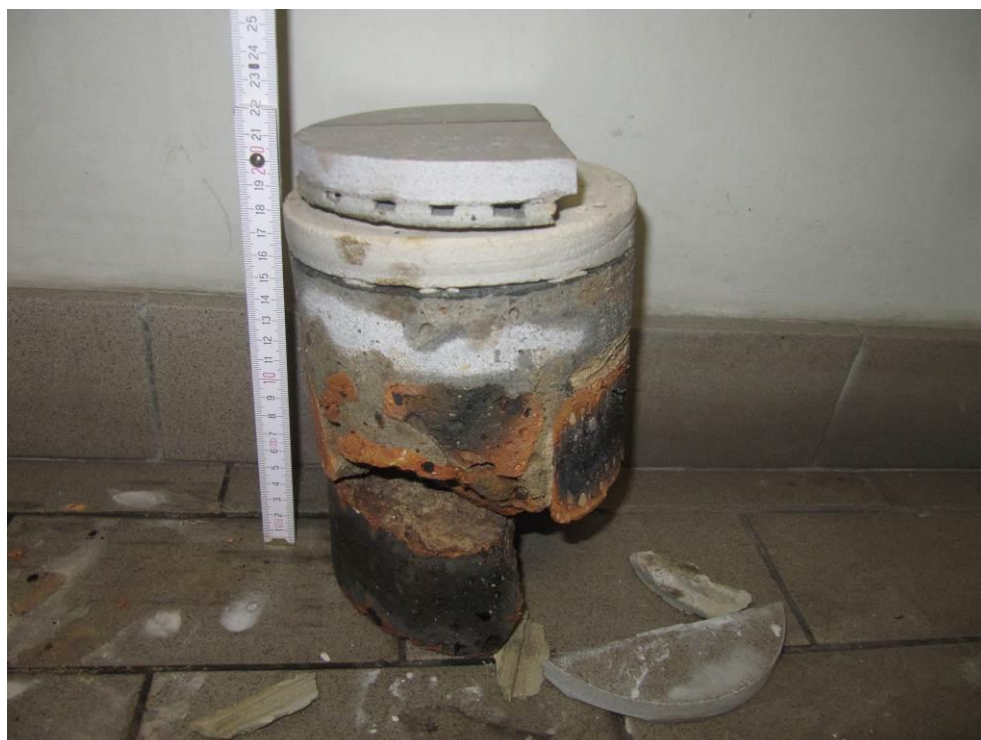
Rys. 9. Odwiert rdzeniowy w podłodze korytarza
