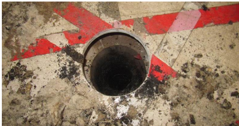
Rys. 6. Otwór rdzeniowy w podłodze pomieszczenia nr 005
