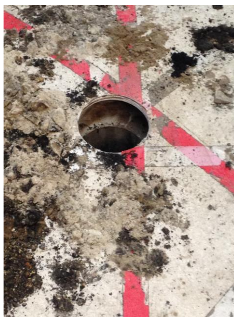
Rys. 2. Otwór badawczy nr 1: a) lokalizacja, b) widok pustki.
