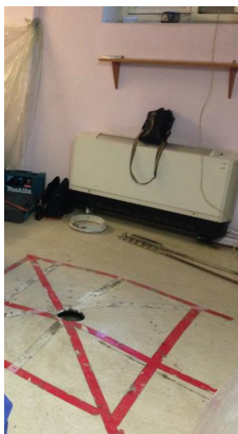
Rys. 2. Otwór badawczy nr 1: a) lokalizacja, b) widok pustki.
